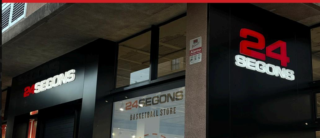
Composite troquelado y adaptado para revestir la fachada. Metacrilato sin rotular e iluminado mediante cajón de luz en la parte posterior.
